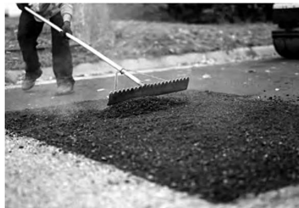
изведён ямочный ремонт, включая ремонт картами, в том числе улицы Ларина, где традиционно из за напряжённого транспортного потока большая колеиность.
